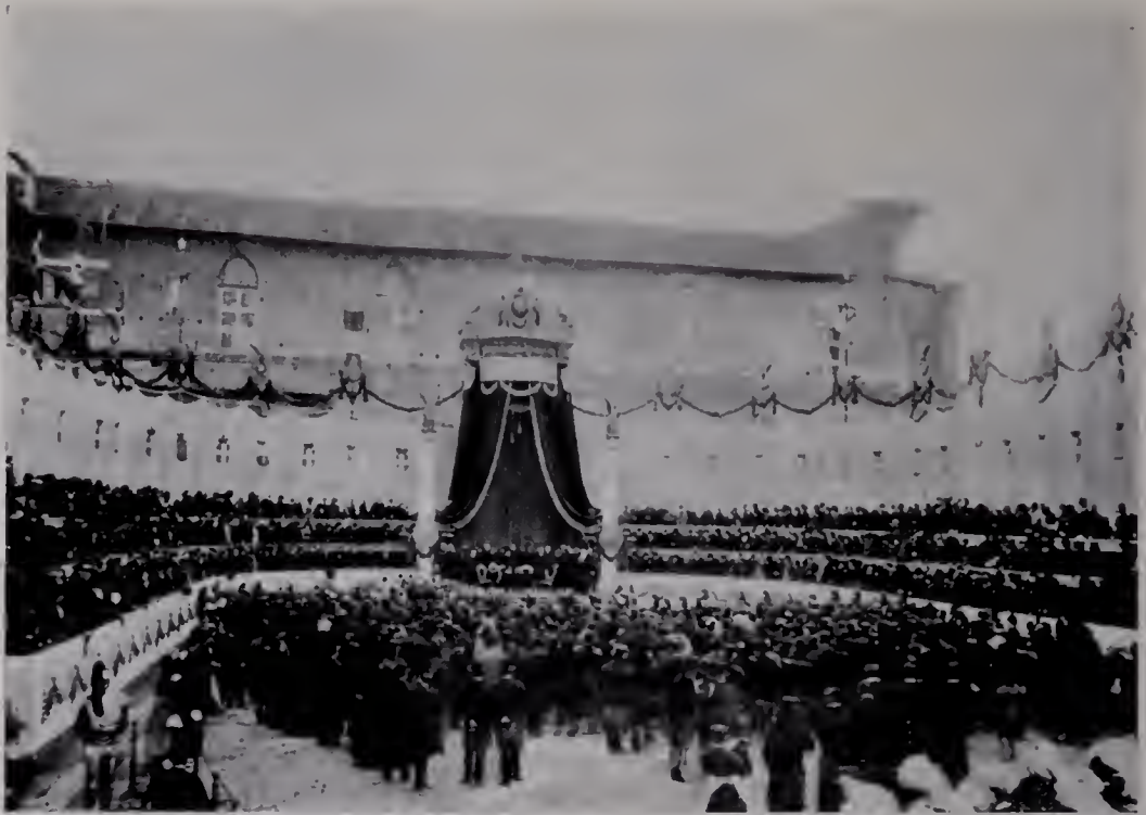
72. — La posa della prima pietra
